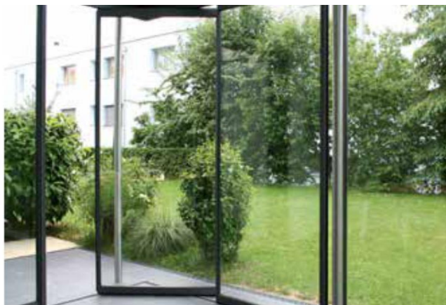
Možnosť zapustenia vodiacej koľajnice do podlahy - bezprahové vstupy. Systém umožňuje celospločné otváranie aj cez rohy.
